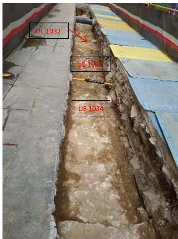
Fig.8- Vista en direcció nord de les UE 1032,1033 i 1034, afectades pel rebaix que s'ha de fer per tal de passar els nous serveis sota el tub de gas.
