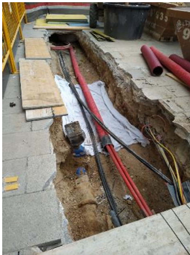
Fig.63-Cobriment amb geotèxtil de l'estructura de la rasa de la Plaça Nova.
