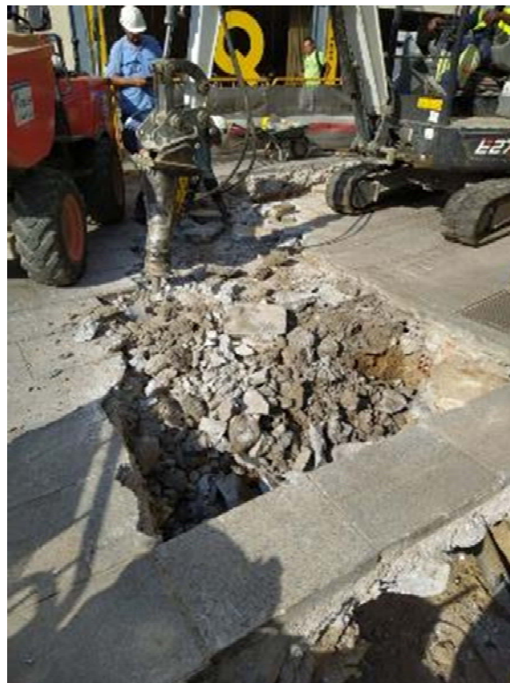
Fig.27-Fotografia dels treballs executats en l'obertura del tram de rasa comprès entre la part sud del carrer dels Arcs i la plaça Nova.
