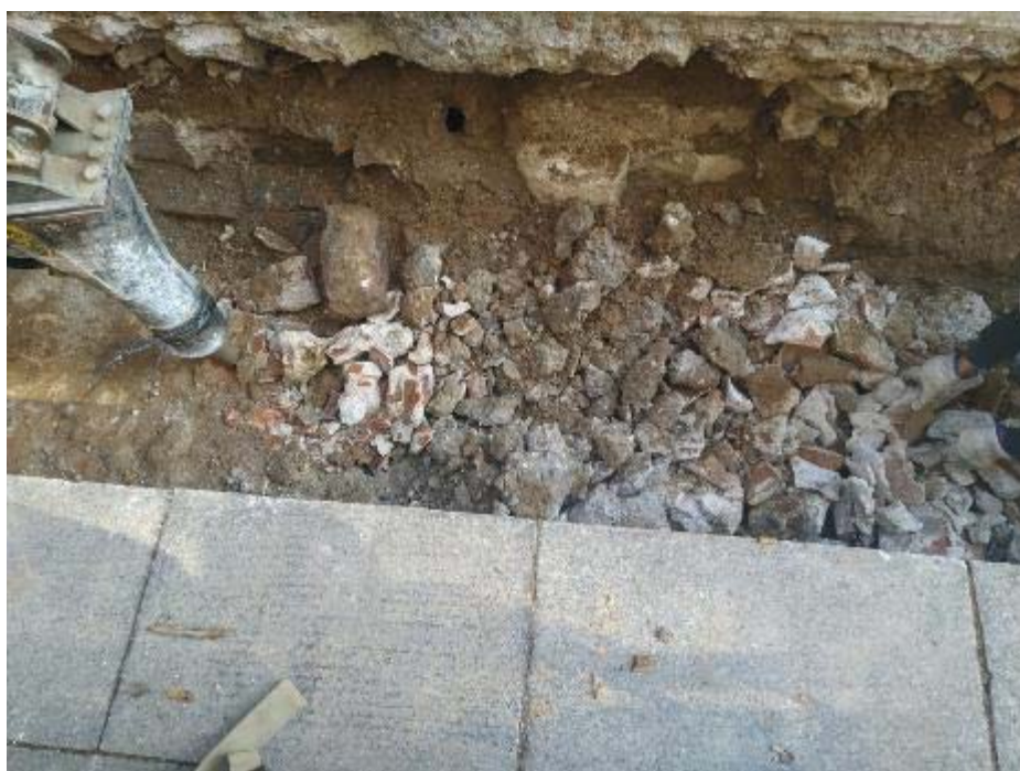
Fig.45.- Treballs de desmuntatge desmuntatge de les estructures de la primera rasa efectuada al Carrer dels Arcs.
