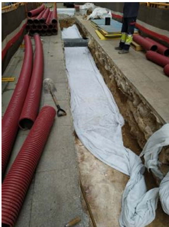
Fig.52- Cobriment de la rasa del Carrer dels Arcs.
