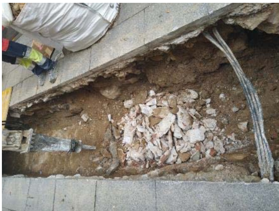
Fig.43- Treballs de desmuntatge de les estructures de la primera rasa efectuada al Carrer dels Arcs.
