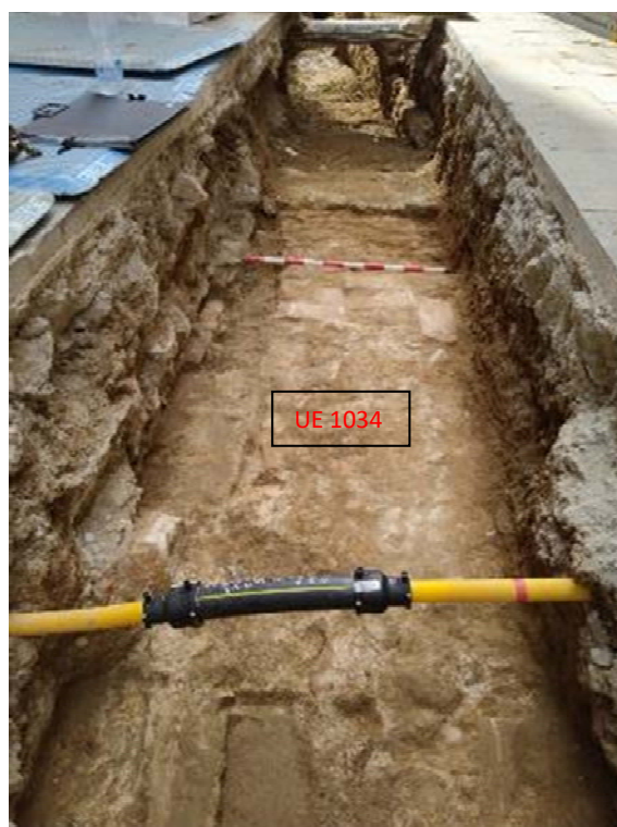
Fig.10-Vista en direcció Sud, del tub de gas i de la UE 1034.
