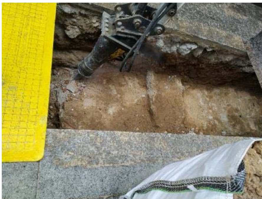
Fig.42- Treballs de desmuntatge de les estructures de la primera rasa efectuada al Carrer dels Arcs.
