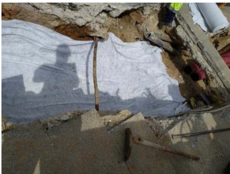
Fig.61- Cobriment amb geotèxtil de les estructures de la rasa entre el Carrer dels Arcs i la Plaça Nova.
