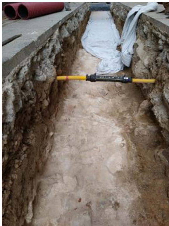
Fig.53.- Cobriment de la rasa del Carrer dels Arcs.
