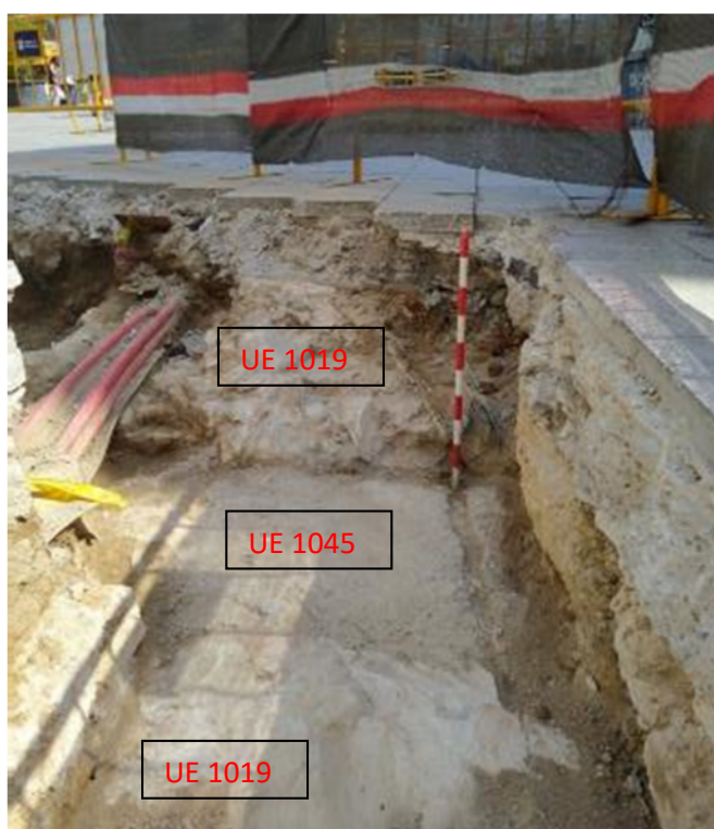
Fig.31-Sector sud de la rasa.
