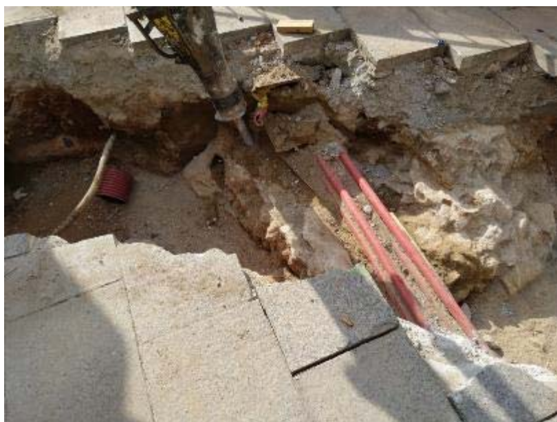
Fig.58-Desmuntatge de l'estructura UE 1019 a la rasa entre el Carrer dels Arcs i la Plaça Nova.
