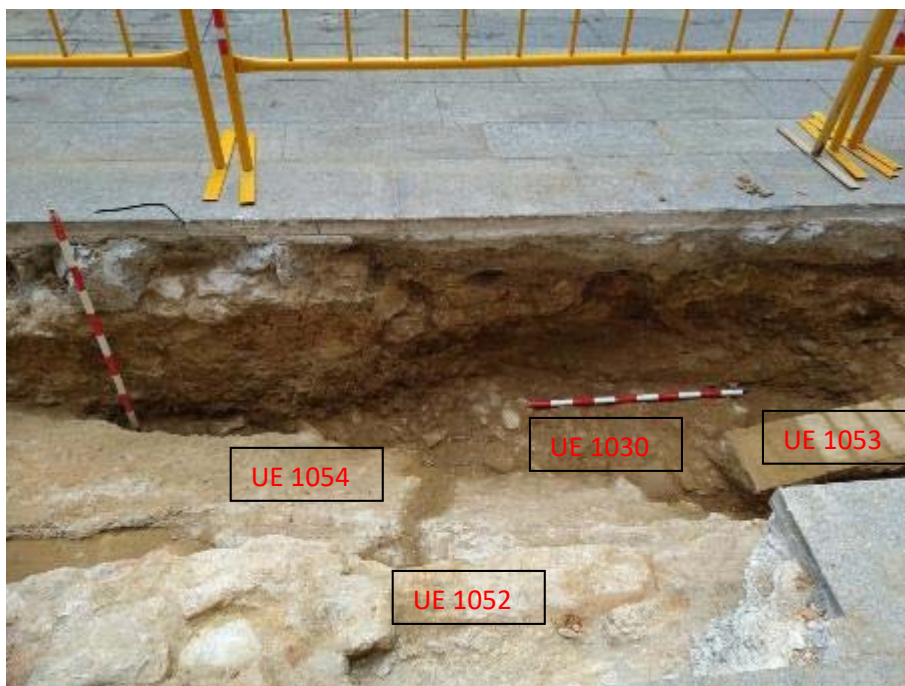
Fig.77- Estructures aparegudes a la part meridional de la rasa del Carrer dels Arcs.
