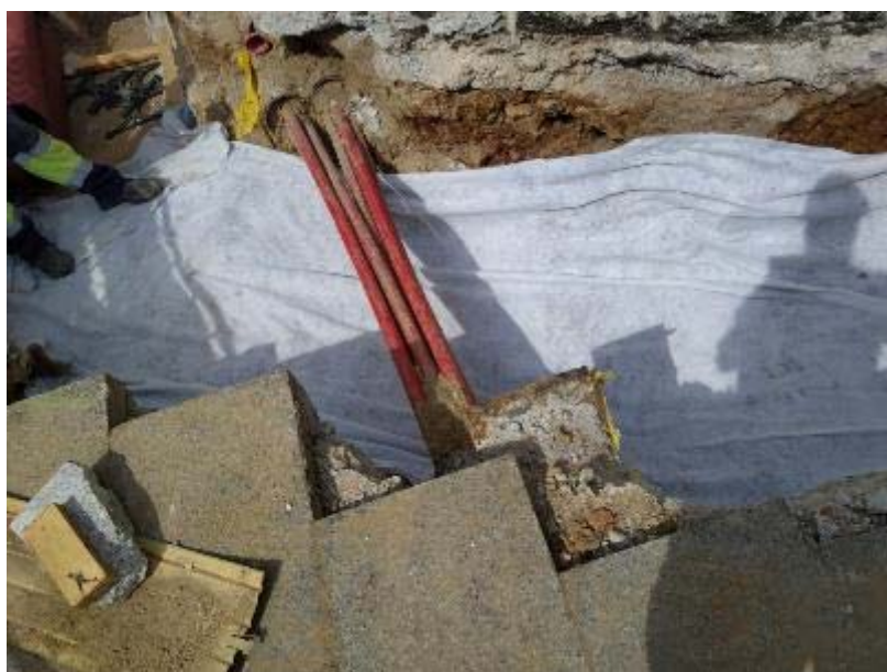
Fig.60-Cobriment amb geotèxtil de les estructures de la rasa entre el Carrer dels Arcs i la Plaça Nova.
