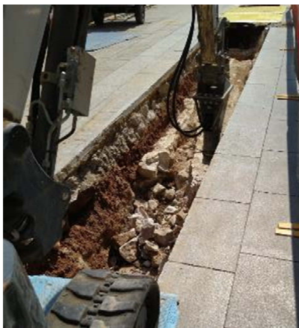
Fig.48.- Treballs de desmuntatge de les estructures de la primera rasa efectuada al Carrer dels Arcs.
