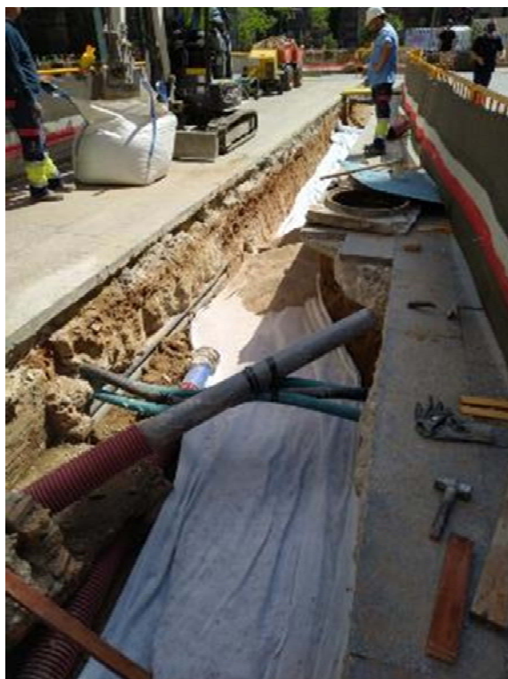
Fig.54- Cobriment de la rasa del Carrer dels Arcs.
