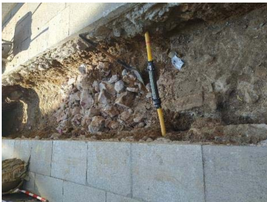
Fig.46- Treballs de desmuntatge de les estructures de la primera rasa efectuada al Carrer dels Arcs.
