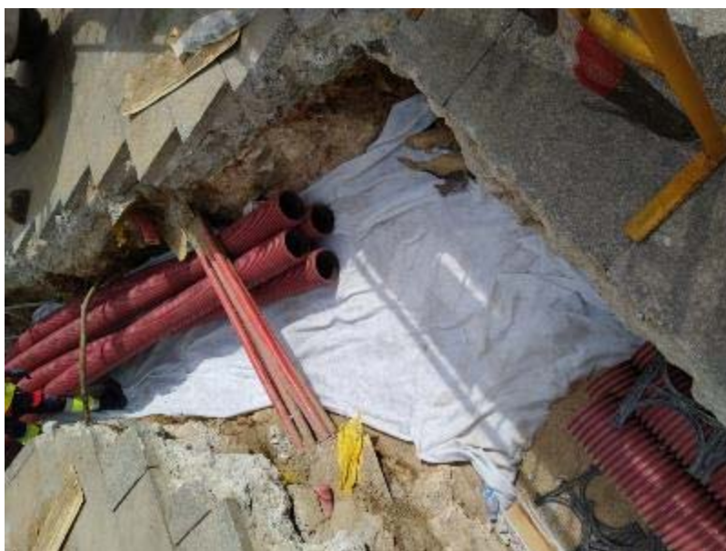
Fig.62- Cobriment amb geotèxtil de les estructures i col·locació de tub de la rasa entre el Carrer dels Arcs i la Plaça Nova.
