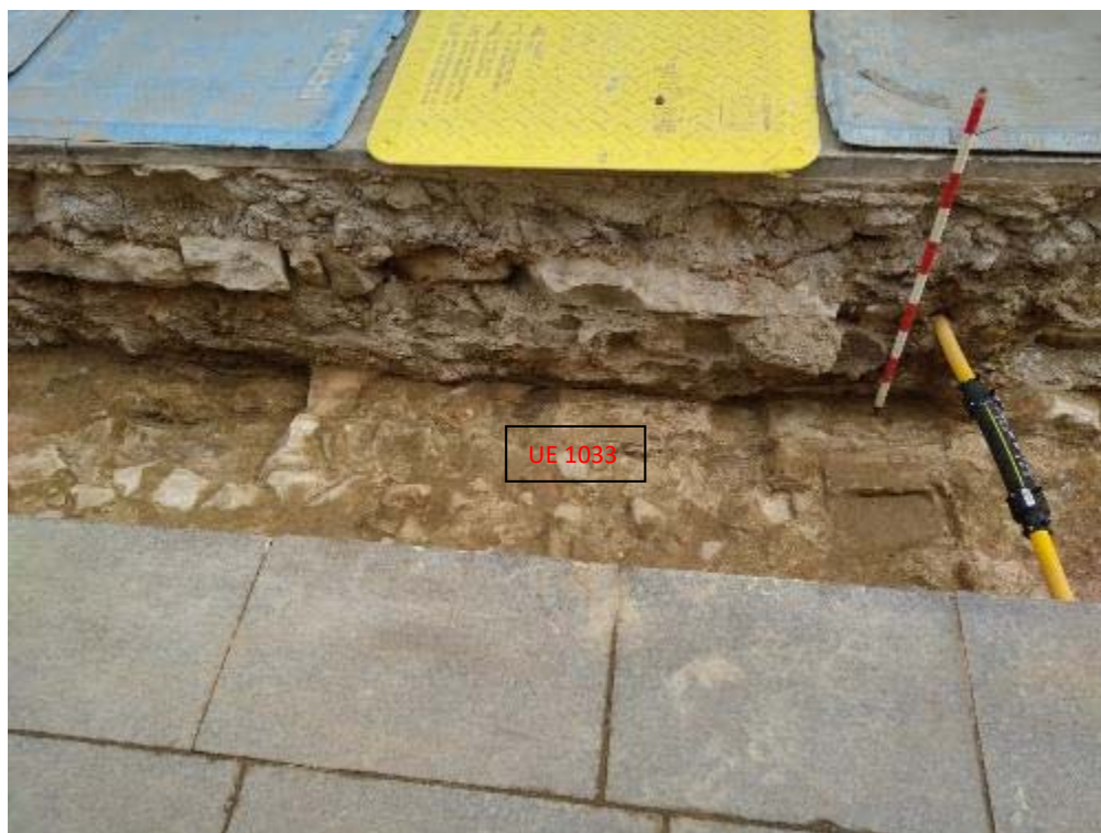
Fig.9-Vista de la UE 1033 i el tub de gas.
