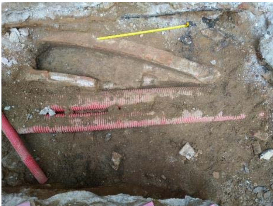
Fig.85-Fotografia on s'observa un clavegueró al final del Carrer dels Arcs (tallat per cables de mitja tensió), d'una factura molt similar a les estructures anteriorment trobades, i amb una solera de rajoles de 30 cm. x 15 cm.
