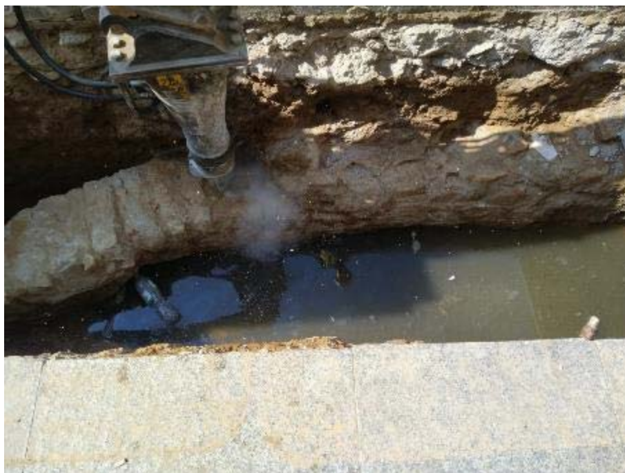
Fig.47.- Treballs de desmuntatge desmuntatge de les estructures de la primera rasa efectuada al Carrer dels Arcs.
