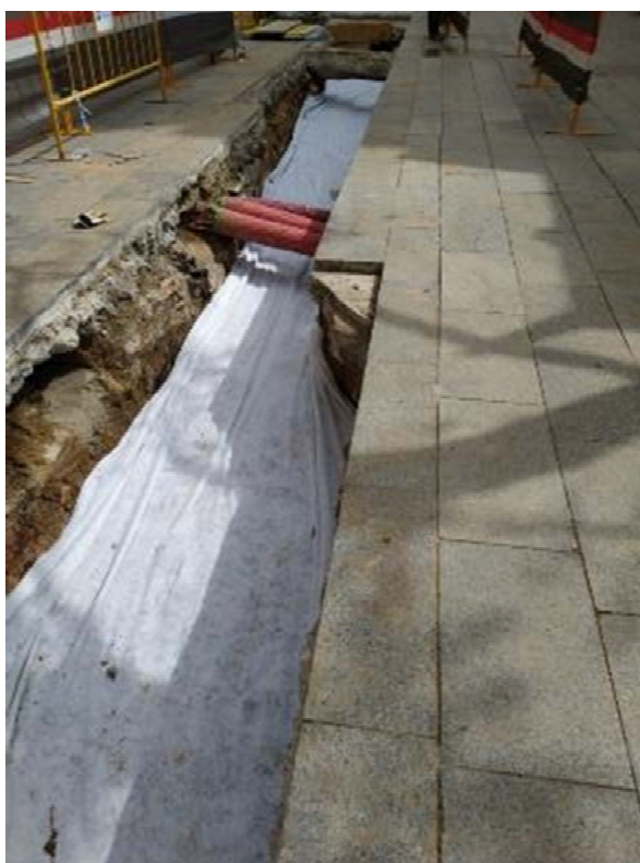
Fig.88- Cobriment de les estructures a la part nord de la rasa del Carrer dels Arcs.
