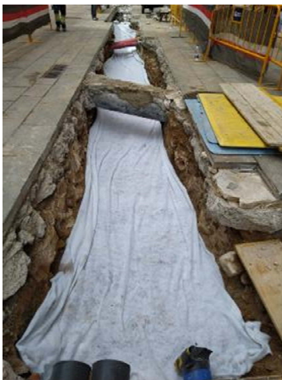
Fig.87- Cobriment de les estructures a la part nord de la rasa del Carrer dels Arcs.
